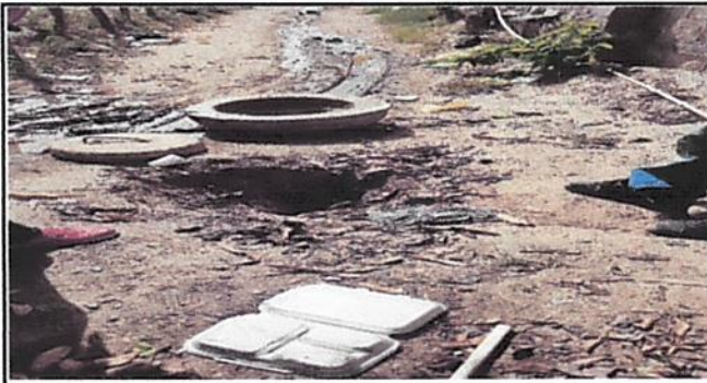
Foto 3: REPARACION DE DRENAJE
