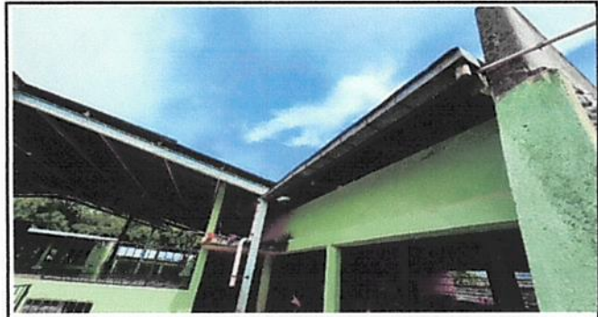
Foto 4: CAMBIO DE CANAL Y BAJADAS DE AGUA PLUVIALES
