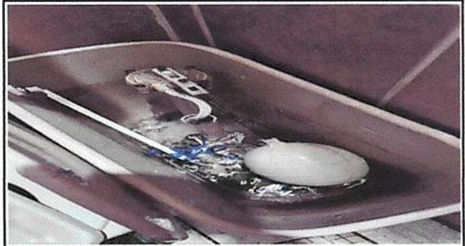
Foto 2: REPARACION DE TAZAS SANITARIAS
